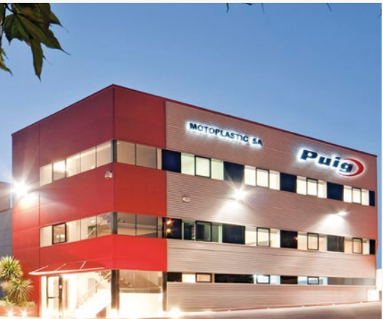
Umbau des Hauptsitzes von Puig in Granollers.
